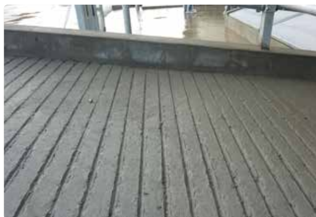
Figur 5.37 En god profivering af rampen er et godt udgangspunkt for en skridtsikker rampe.
