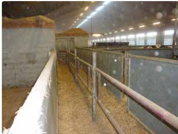
Figur 3.17 En drivgang med en parallel persongang giver mulighed for at gå ved siden af og drive dyrene frem. For at undgå at slagtekalve springer, bør det øverste rør dog være mindst 1,5 meter over gulvet. Se "Tabel 3.2 Anbefalede mål på drivgange og ramper".
