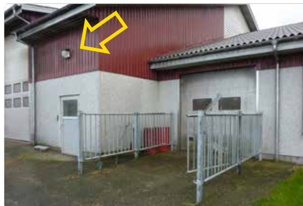
Figur 5.3 Her er tremmelåger, der sikrer, at dyr, der skal udleveres, ikke kommer på afveje. Der er 2,8 m. mellem lågerne, der går ca. 3,5 m ud fra muren. På hver af de midterste stolper sidder en ekstra låge. De ekstra låger er lukket, indtil lastbilen er klar til læsning. Det er også en låge i portåbningen, så dyrene ikke går tilbage ind i stalden. Bemærk at der er lys på muren ved siden af udleveringen (gul pil), så overgangen fra lyset i stalden og til lyset i bilen, ikke bliver så kontrastfyldt. Lys ved porten ville fuldende løsningen.
