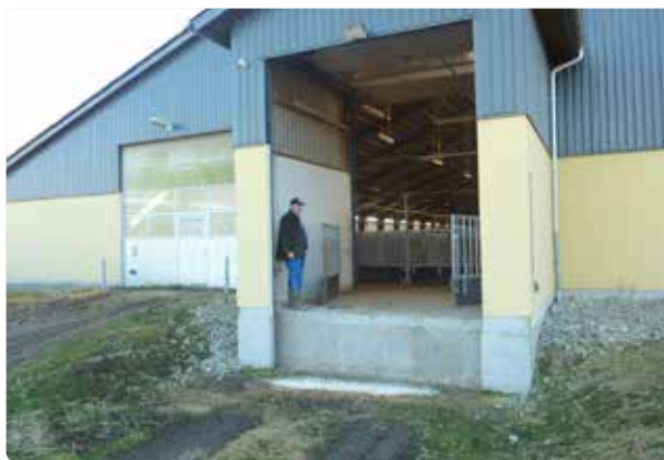
Figur 5.40 Et lille fald i terrænet udnyttes fint. Lastbilen kører lidt ned, og dyrene skal kun gå ca. 20 cm op. Bemærk at der er sensorstyret lys over porten. Porten kan også åbnes udefra.
