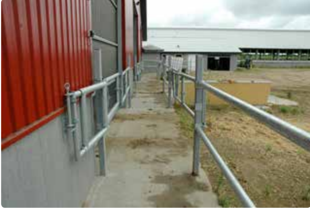
Figur 3.14 Udendørs drivgang som forbinder to stalde og samtidig fører til udleveringsrummet, der er indrettet i en bygning mellem staldene.
