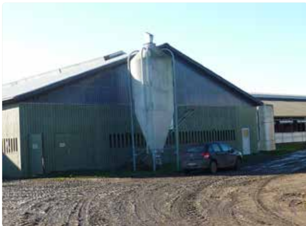
Figur 5.20 I denne gavl er der, efter ombygning, indrettet et udleveringsrum. Længst til venstre er der indgang for inseminør/dyrlæge, dernæst er der en dobbeltdør, som er udgang for udleveringsdyrene og længst til højre er der adgang til hånd- og støvlevask for chaufføren (hvid dør).
