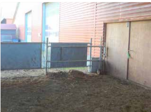
Figur 5.17 Fra stalden er der direkte adgang for dyrene til udleveringsrummet via dobbeltdøren til højre. Bunden er belagt med gummimåtter og strøet med spagnum. Uden spagnum kan gulvet let rengøres og gummi udgør et fint underlag. Der er en hjælpelåge til at lede dyrene hen til udgangen.
