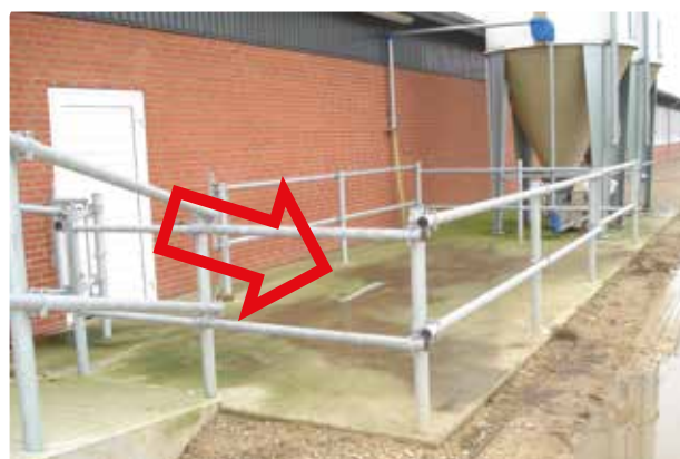
Figur 1.5 I selve udleveringsboksen er det betonbund med fald til afløb (rød pil).
