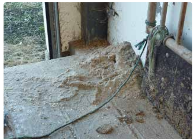
Figur 3.23 Vandret indendørs rampe, der er 4,3 meter bred. Gulvet er profileret beton, som strøes med sand for at opnå god skridsikkerhed. Lågerne inden for porten sikrer, at chaufføren kan gøre klar, inden kalvene slippes løs.
