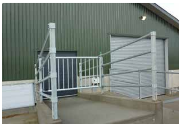
Figur 5.38 Solidt og højt hegn i siderne, så ingen dyr springer over. Lågen midt på rampen, giver dyrene mulighed for at komme frem og snuse lidt til rampen, imens bilen bakker til.
