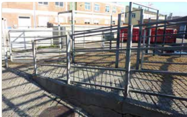
Figur 5.35 Selv på slagteriet, hvor der er dyb profivering i ramperne, bliver rampen glat, når der kommer fugtig gødning og livlige kreaturer på dem. Et par skovlfulde sand forbedrer skridtsikkerheden.
