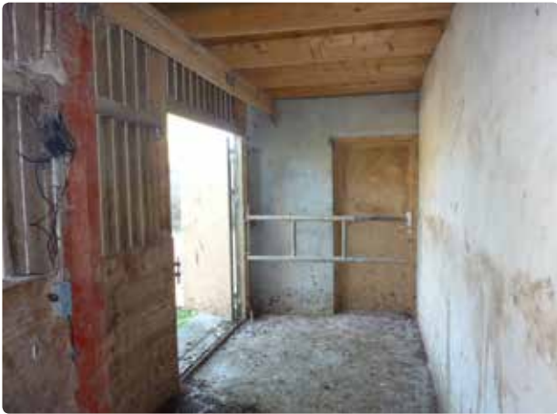
Figur 5.22 Dyrene kommer ind i udleveringsrummet via døren for enden af rummet og ud via dobbeltdøren til venstre. Chaufføren læsser selv og kommer slet ikke ind i selve stalden.
