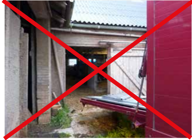
Figur 3.33 Det er besværligt, når der skal bakkes skråt til og der er risiko for, at rampen river tagrenden ned, når den sænkes. Her er det nødvendigt at bakke til, sænke rampen, og derefter bakke det sidste stykke. Det er besværligt og tager ekstra tid.
