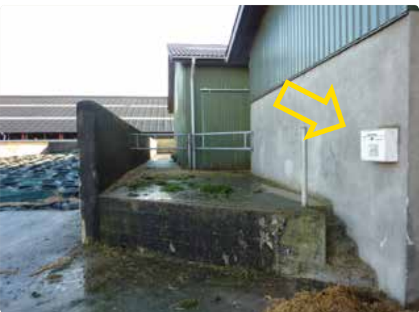
Figur 3.28 Niveauforskellen udnyttes så dyrene ikke skal gå på en stejl rampe. Postkassen anbringes naturligvis lige ved siden af rampen. Plansiloelementet giver læ til dyr på udleveringsrampen.
