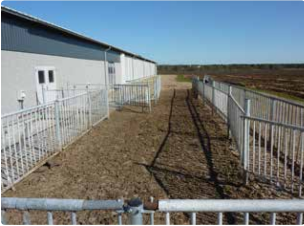
Figur 5.29 Uvendørs udleveringsboks med rampe (længst væk). Hele området er ca. 90 m 2 . Der er mulighed for inddeling i flere bokse. Stedet anvendes også til klovbeskæring og interne flytninger. Med overdækning og afløb kan området rengøres, så der ikke overføres smitte, når området bruges til flere formål.
