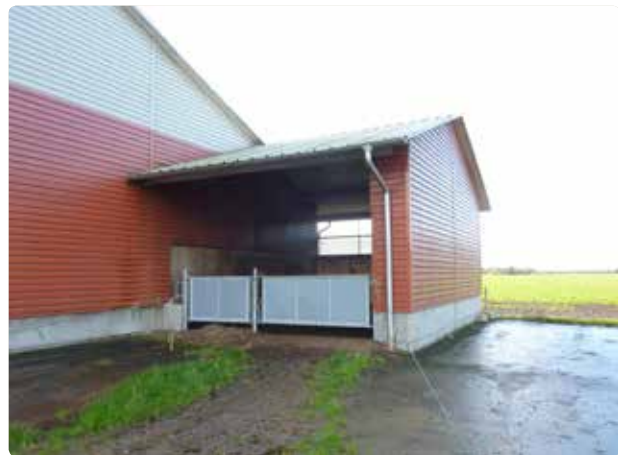
Figur 5.16 Her er udleveringsrummet en tilbygning til stalden på 45 m 2 . Gode tilkørselsforhold: asfaltvej.
