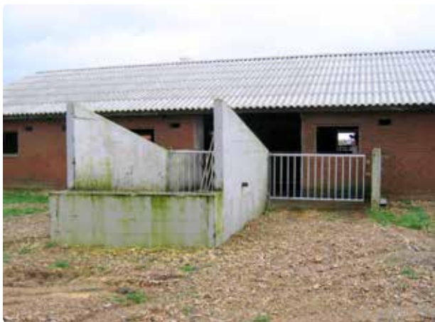
Figur 3.21 Rampe hvor den sidste ½ meter er vandret, og betonmurerne giver læ.
