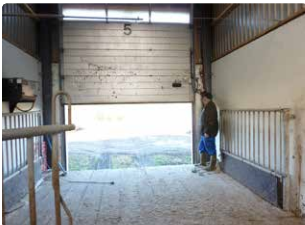
Figur 3.23 Vandret indendørs rampe, der er 4,3 meter bred. Gulvet er profileret beton, som strøes med sand for at opnå god skridsikkerhed. Lågerne inden for porten sikrer, at chaufføren kan gøre klar, inden kalvene slippes løs.
