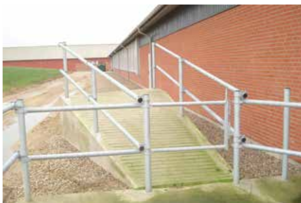
Figur 1.4 Der er en låge imellem boksen og rampen, så dyrene får ikke adgang til rampen, før de skal op i bilen. Rampen er profileret for at give bedst mulig skridtsikkerhed.
