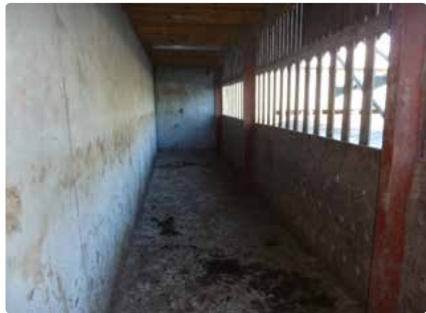
Figur 5.23 Det aflange udleveringsrum, som går i næsten hele gavlens bredde, 16 meter lang og 2 meter bredt. Der er 2 lysstofrør i loftet, som tændes ved dobbeltdøren. Der er afløb i gulvet, som dog altid er tørt, måske pga. god ventilation. Gulvet renholdes med skrabning med bobcat.
