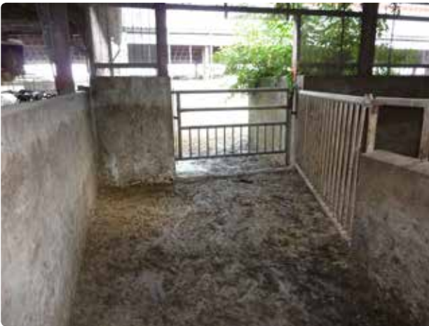
Figur 3.16 Undgå "blinde hjørner" som det her til venstre (gul pil), hvor nogle dyr kan blive fanget. Undgå også beslag, der "stikker ud" og som kan skade dyr, der bevæger sig hurtigt fremad – og presses/skubbes af de dyr, som kommer lige efter. En plade kan skærme hjørnet af og lede alle dyr direkte imod åbningen.
