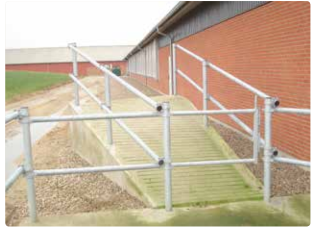
Figur 5.27 Der er en låge imellem boksen og rampen, så dyrene får ikke adgang til rampen, før de skal op i bilen. Rampen er profileret for at give bedst mulig skridsikkerhed.
