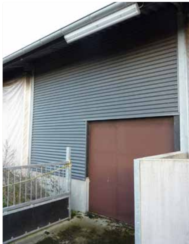
Figur 5.32 Køerne venter i separationsboksen bag den brune skydeport. Bemærk at der er lys over udgangen, så dyrene også i mørke kan se, hvor de skal hen. Der er også et mandehul lige til venstre for porten.
