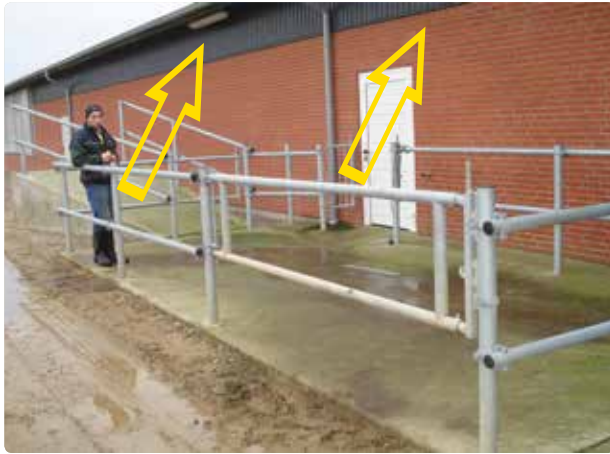
Figur 5.26 En udendørs udleveringsboks med rampe. Der er monteret lys to steder under udhænget. Pilene viser, hvor de sidder, men kun det ene kan ses på billedet.
