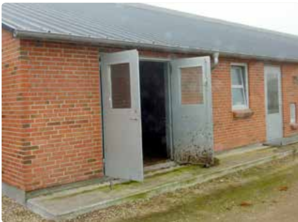
Figur 5.15 Der er udgang fra udleveringsrummet via dobbeltdøre. Ejeren mener, at en skydeport her havde været bedre, så kunne chaufføren bakke til og slå rampen ned, inden der blev åbnet ind til dyrene i udleveringsboksen.
