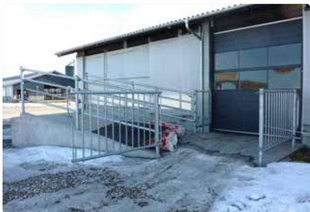
Figur 5.39 Her må dyrene dreje for at komme op ad rampen, til gengæld er det let for lastbilen at bakke til.
