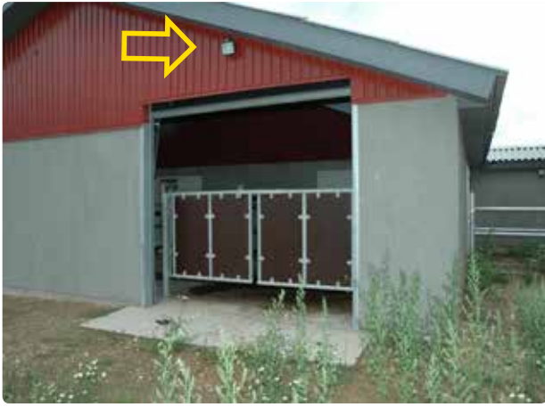
Figur 3.24 Der er lys over porten (gul pil), så det er let at se, hvad der foregår.
