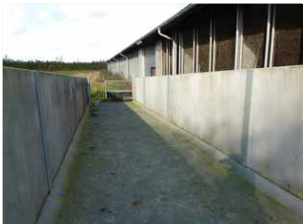
Figur 5.31 En meget lang rampe (ca. 19 meter) med kun ca. 3 % stigning. Siderne består af 1,5 meter høje betonelementer, en usædvanlig kraftig konstruktion, som står her, fordi de blev fejlproduceret til staldbyggeriet. Det er en fordel, at dyrene ikke kan se ud, så forstyrres de ikke i deres fremdrift.
