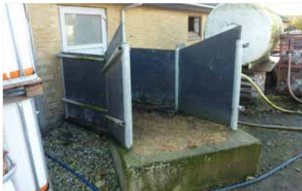
Figur 5.36 Lukkede sider på rampen giver læ og dyrene distraheres ikke af omgivelserne, når de ikke kan se noget.
