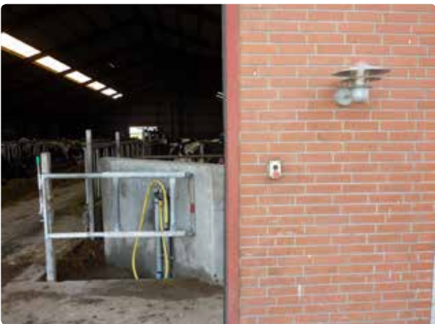
Figur 3.26 Lys på begge sider af porten og med udleveringsboksen lige bag vaskemuren. Lyset skal have styrke af arbejdslys (200 lux).
