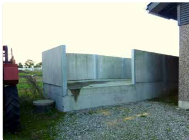
Figur 5.34 Rampens åbning er 2,0 meter indvendigt. Ejeren har efter opførelsen erkendt, at det ville være smart med et mandehul lige til højre for åbningen (i samme side som chaufføren stiger ud af bilen), så han let kan komme bag om de sidste dyr og genne dem ind.
