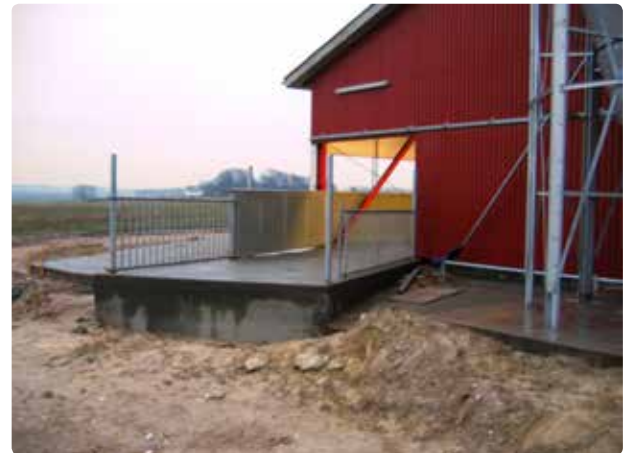
Figur 3.22 Her giver lukkede inventarlåger læ til dyrene på første del af den vandrette rampe, terrænet får lastbilen til at holde lavere end rampen, så dyrene her går næsten vandret ind i bilen. Bemærk lys over porten.
