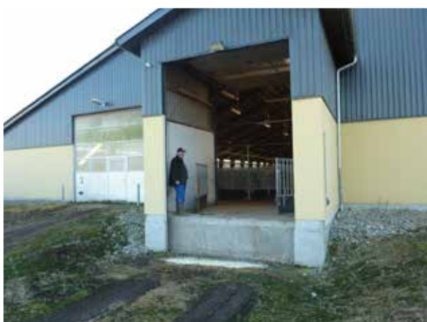
Figur 1.6. Et lille fald i terrænet udnyttes fint, lastbilen kører lidt ned, og dyrene skal kun gå ca. 20 cm op. Bemærk at der er sensorstyret lys over porten, der kan åbnes både inde- og udefra.
